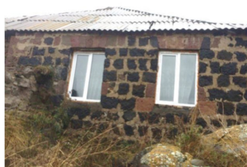
左圖： 裝修好的窗戶及屋頂
